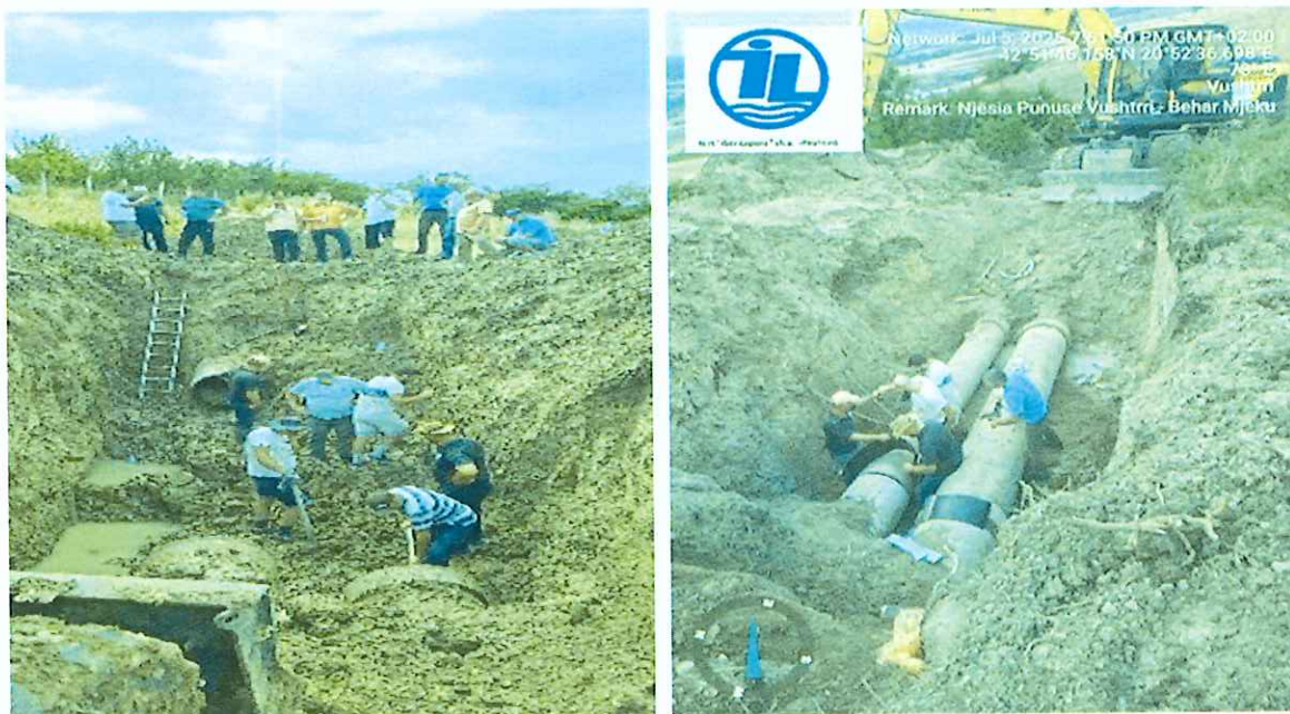
Largimi igypave të dëmtuar Ø 700 dhe Ø 600 dhe vendosja e gypave të ri, në fushën e Mitrovicë
